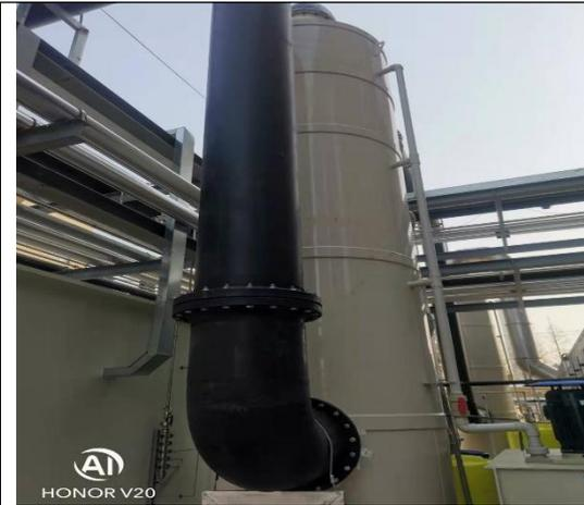
车间工艺有机废气处置装置——酸喷淋塔
