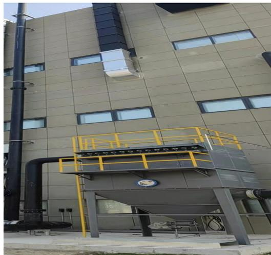
固体产品颗粒物处置装置——布袋除尘器
