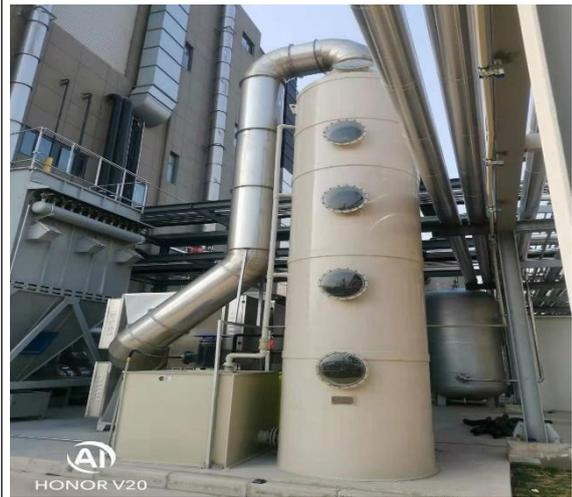
车间工艺有机废气处置装置——碱喷淋塔
