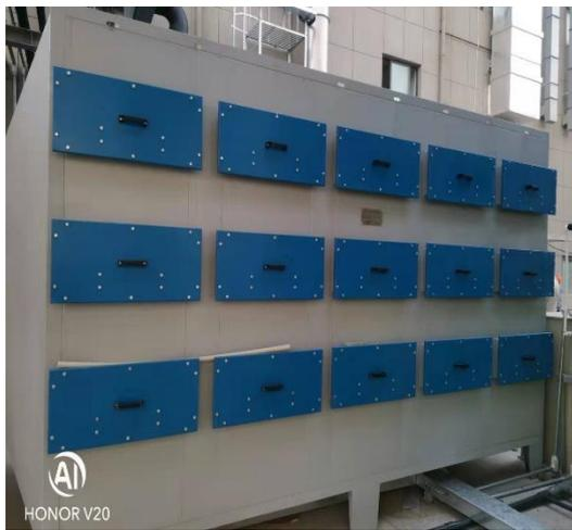
车间工艺有机废气处置装置——UV 光解
