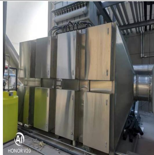
车间工艺有机废气处置装置——活性炭吸附
